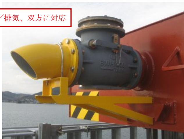
写真 3 安全弁（※ 写真は従来型の BREATHER VALVE）
