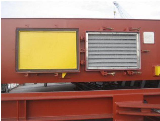
写真 2-1 通風筒のカバー内面塗装
